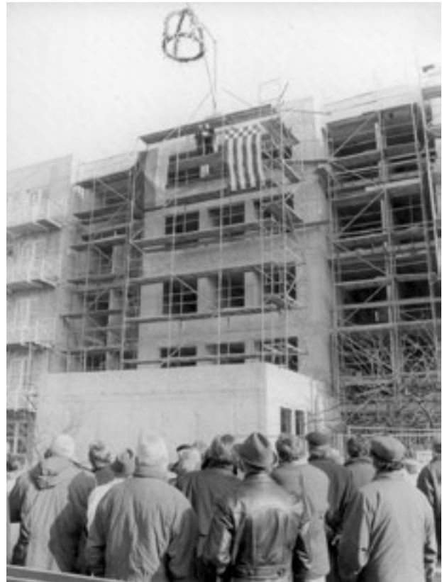
Richtfest zweiter Bauabschnitt
