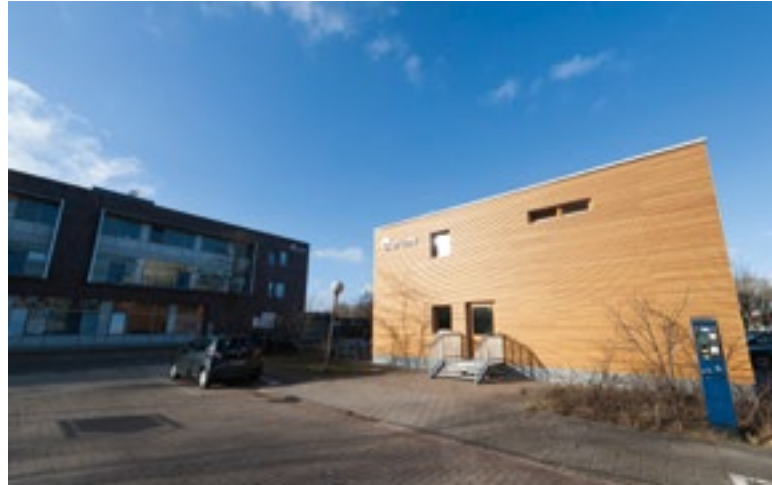
MARUM-Pavillon, neben der Energiezentrale
