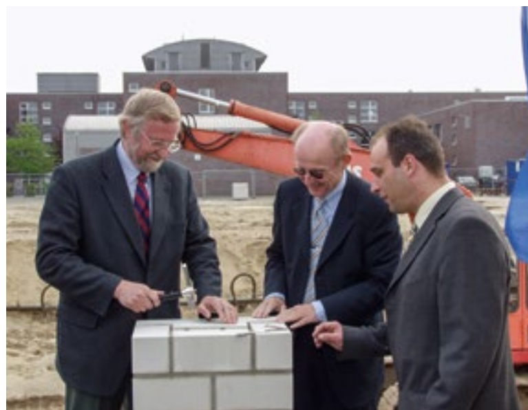
Grundsteinlegung des Gebäudes MARUM 1 mit Senator Willi Lemke (Mitte)
